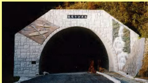
広島県 熊見トンネル
